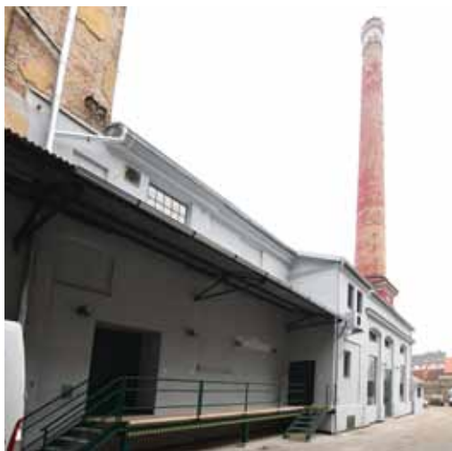
Rekonstrukcí prošla levá zadní část pivovaru.
