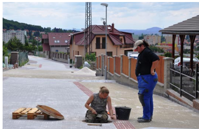
Povrch Broskvové ulice tvoří zámková dlažba. Práce na jejím dokončení finišují. Foto Eva Břeňová
