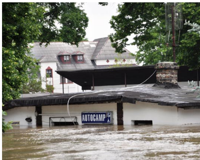
Na snímku vidíme, kam voda v provozní budově autokempu sahala. Více než polovina chatek byla zničena, nebo uplavala. Foto (eva)
