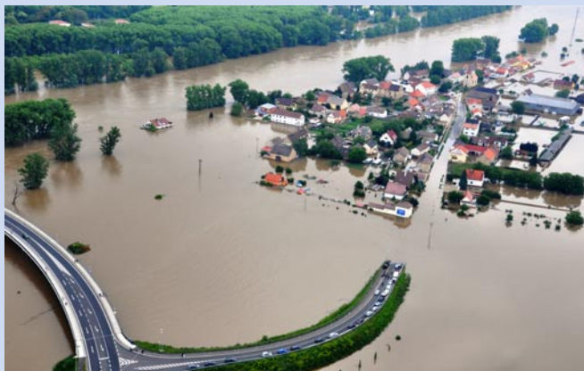
Most generála Chábery byl konstruován tak, aby odolal povodni z roku 2002. Přivaděč do Mlékojed se však z části ocitl pod vodou, stejně jako celá obec. Foto Eva Břeňová
