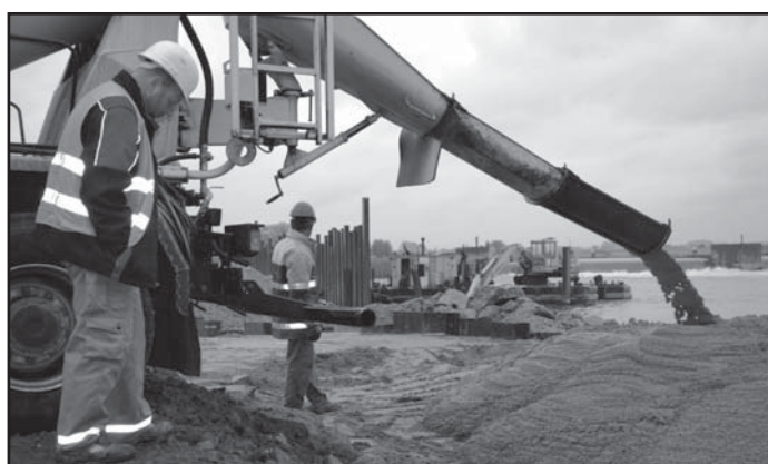
U třeboutického jezu vládne cílý stavební ruch. Foto Eva Břeňová
