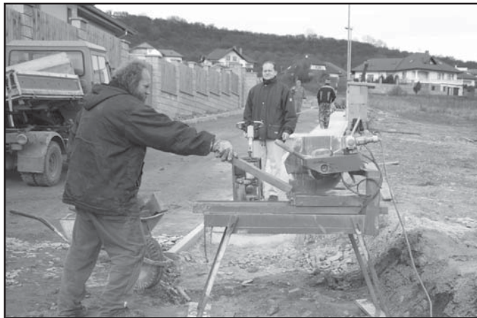
Stavební práce v Hruškové ulici jsou plněm proudy. Zdejší obyvatelé budou mít nejen nové chodníky, ale i silnici. Foto Eva Břeňová
