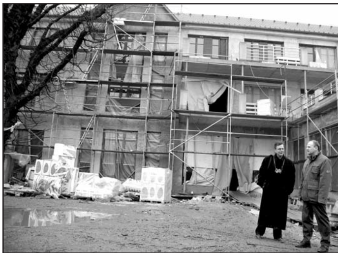
Martin Veber a Jiří Landa při kontrolním dnu na stavbě domova pro seniory.
