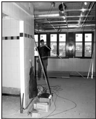
Jeden z právě dokončovaných pokojů s vlastním sociálním zařízením (vlevo) a s již dokončenou vzduchotechnikou.
